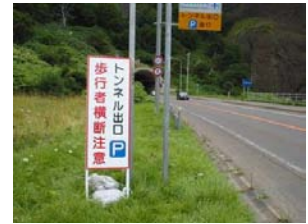
図10 速度抑制注意喚起看板設置
