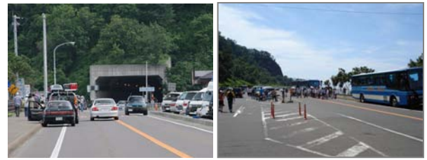
図6 オシンコシン駐車場の状況
