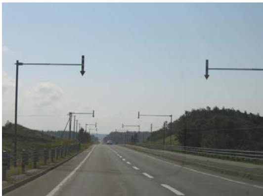
写真-7 スカイラインへの突出あり
