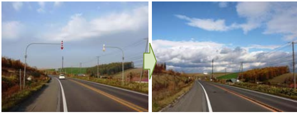
図—18 固定式視線誘導柱の適正化事例
