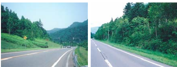
図—6 のり面の緩勾配化と植生回復
