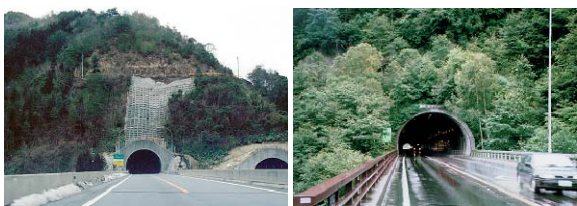
図—7 周辺環境との共存が視覚的に現れる坑口
