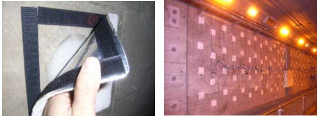
(a) マジックテープによる固定 (b) 電熱ヒータによる防寒養生
