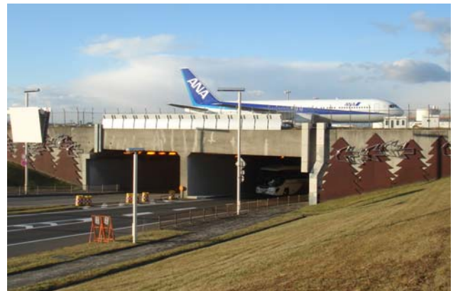
図-1 新千歳空港地下道
