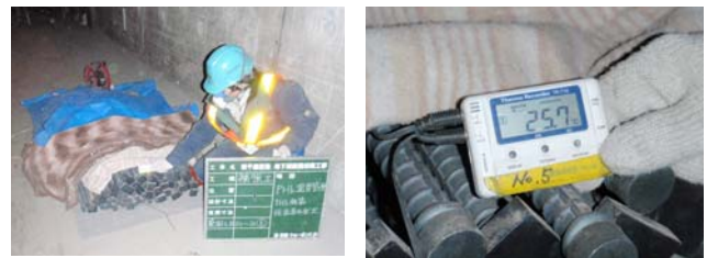
(a) PHb 保温状況 (b) 保温温度
