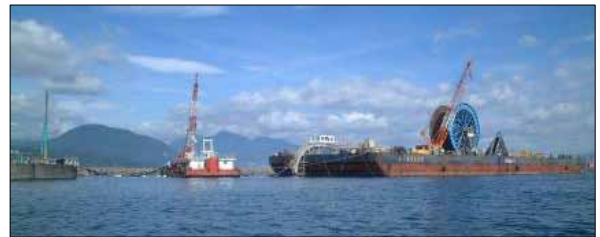
写真-7 取水管敷設の施工状況
