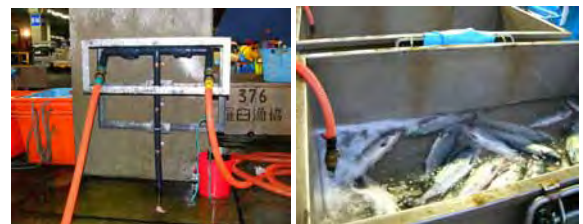
写真-5 岸壁給水栓とタンクへの供給
