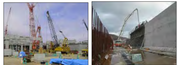
写真-9 人工地盤の施工、アクセス道路の施工
