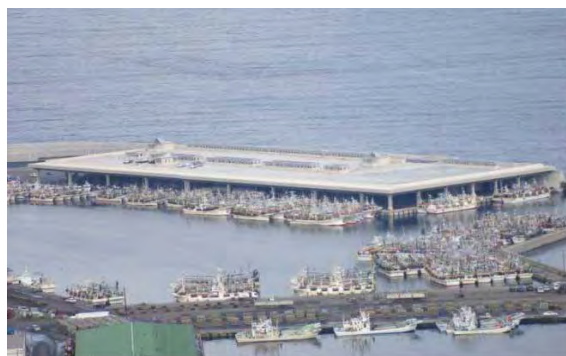
写真-2 全天候埠頭施設全景
