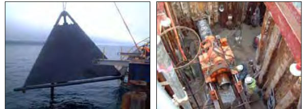
写真-8 取水口設置、取水室の施工状況
