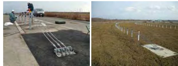
写真-7 直線区間 (左) とカーブ区間の施工状況 (右)
