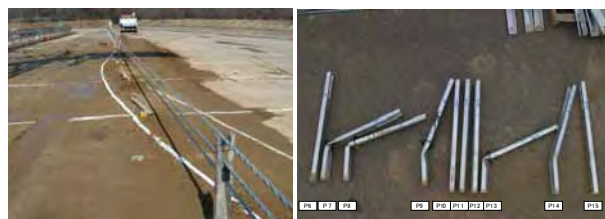
写真-10 衝突後の状況と損傷した支柱
