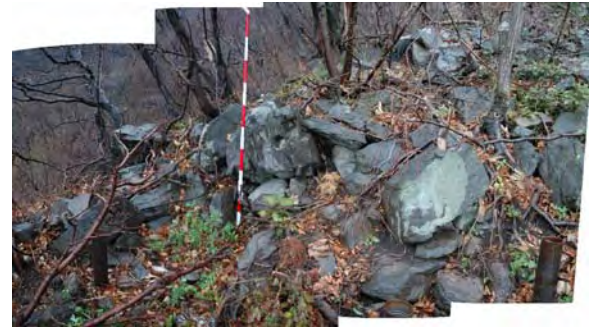
写真-7 法面上方の転石状況(1mクラス)。無数に分布している。
