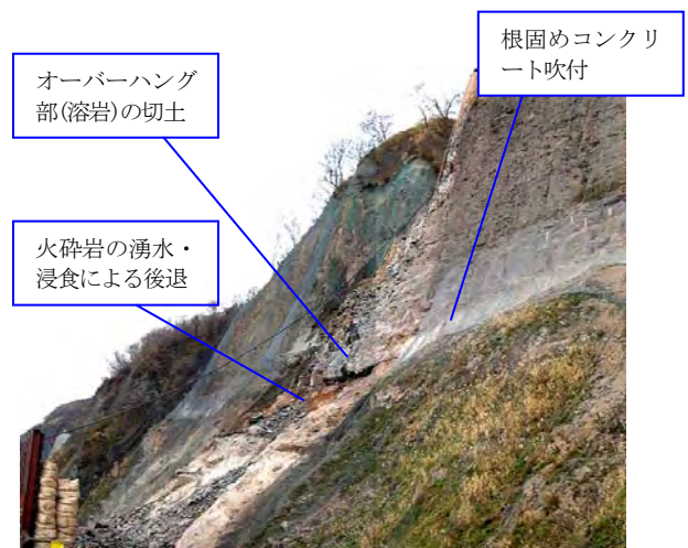
写真-4 H16.9 対策工施工時の状況
