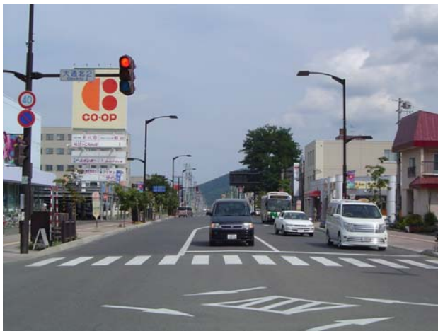
写真-2 平成18年施工後の状況
