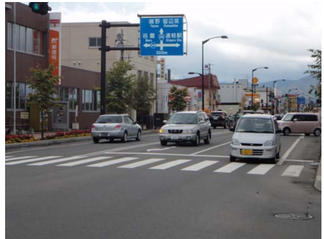
写真-4 施工後の状況 2
