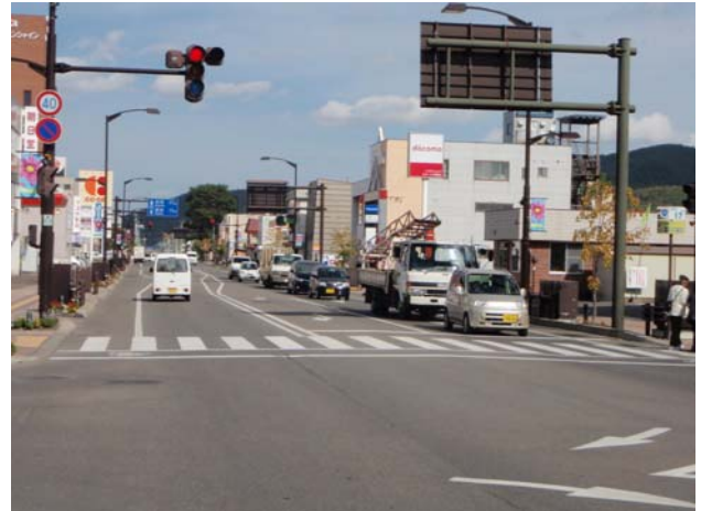
写真-3 施工後の状況 1
