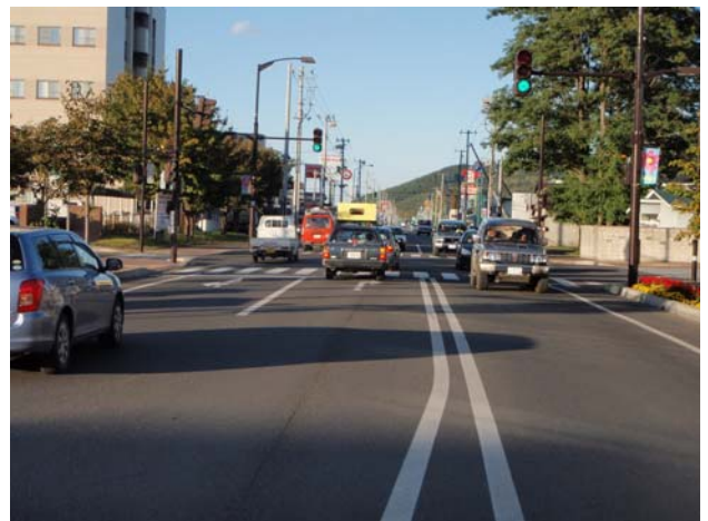
写真-5 施工後の状況 3
