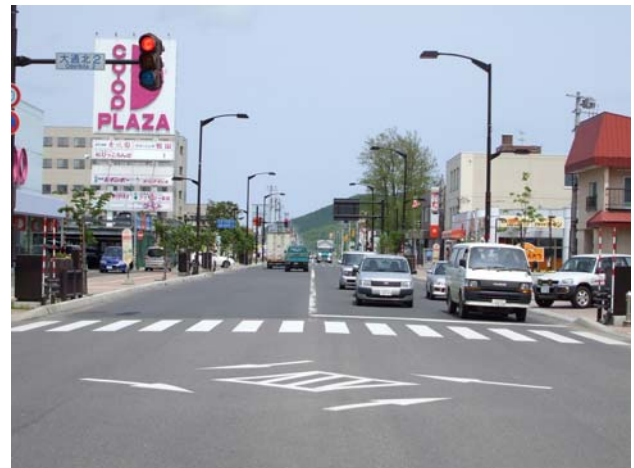
写真-1 見なし4車線状況（施工前）
