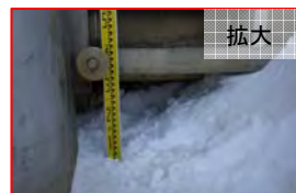
※積雪により生じた開口部 写真-7 十勝B樋門 開口部拡大写真(H21.2.23)
