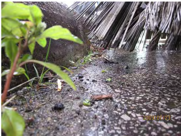
写真-9 縁石と車道舗装端部の状況
