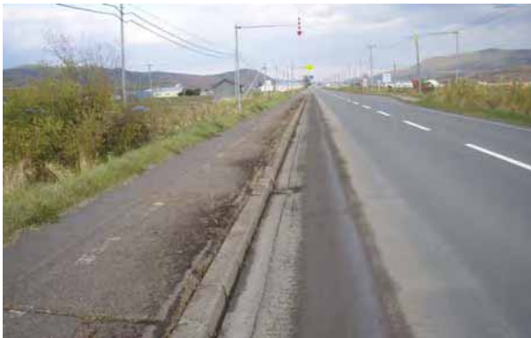
写真-18 第4回試験施工後
