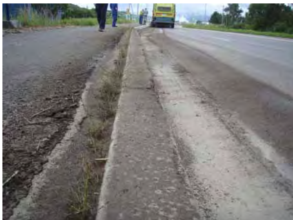
写真-14 第2回試験施工実施後
