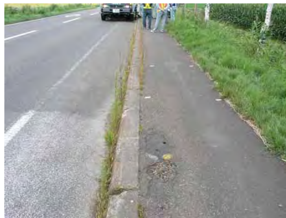
写真-15 第3回試験施工実施前
