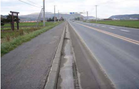
写真-19 除草後の路面
