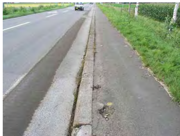
写真-16 第3回試験施工実施前
