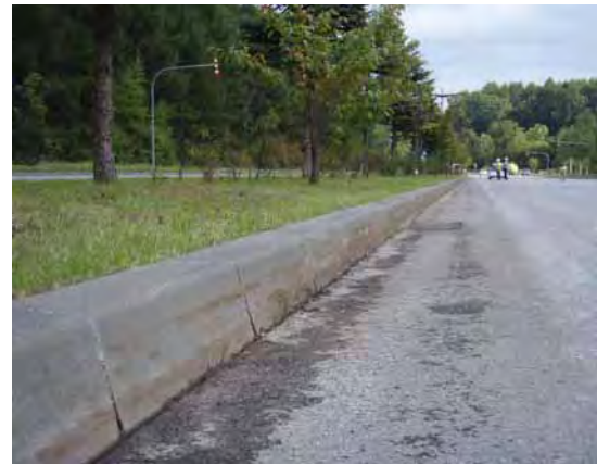
写真-5 試験施工後
