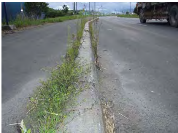
写真-13 第2回試験施工実施前
