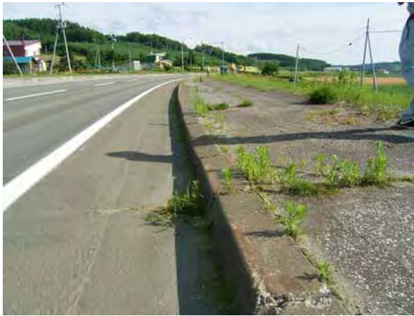
写真-7 第1回試験施工実施前
