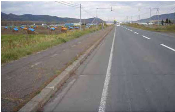
写真-17 第4回試験施工前
