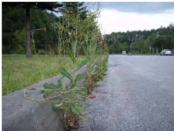
写真-4 試験施工実施前
