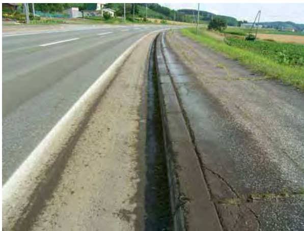
写真-8 第1回試験施工実施後
