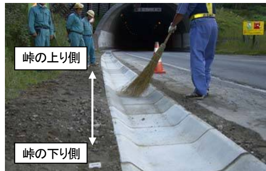
写真-2 皿形側溝の試験施工状況 (7合目付近)
