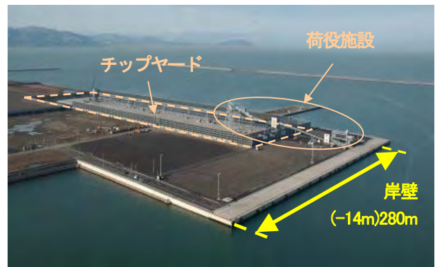
図-4 木材チップ取扱施設
