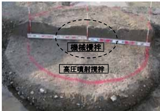
写真-2 杭頭部切断状況
