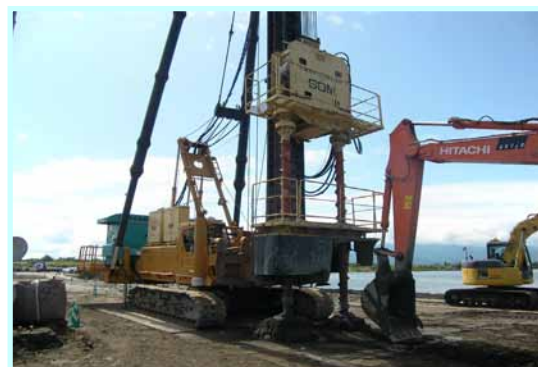
写真－1 施工状況
