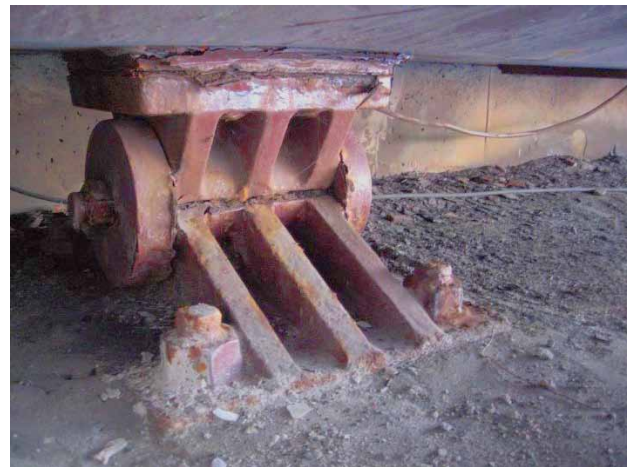
写真-2 鋼製支承の状況
