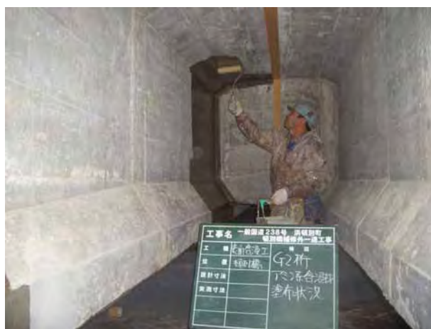
写真-3 施工状況 (G2、含浸性防錆材の塗布)
