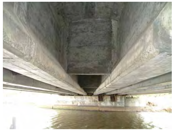
写真-2 主桁の状態
