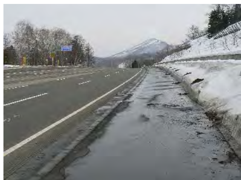
写真-4 グルーピング施工後の状況
