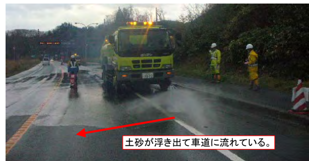
写真-7 清掃時に土砂が車道に流出している状況
