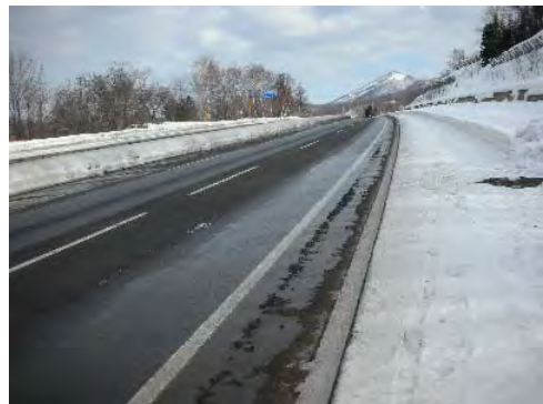
写真-3 グルーピング施工前の状況
