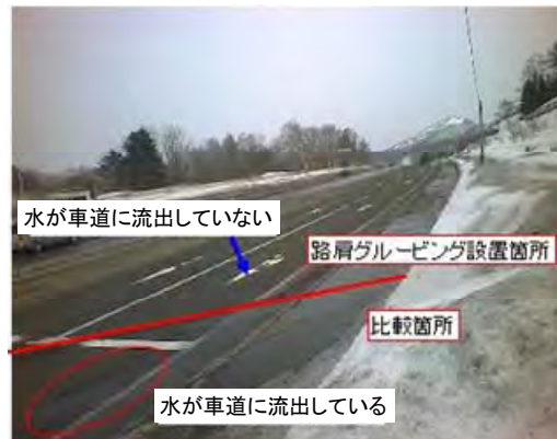
写真-5 路肩グルーピングの遮水状況
