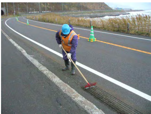
写真-8 人力清掃(レーキ)による清掃状況
