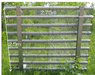
写真-2 ネット工による支持面材への対策例
