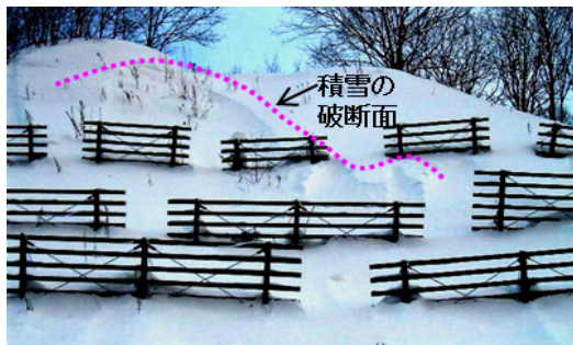
写真-1 すり抜け現象を伴う雪崩の発生事例
