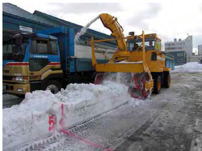
図-15 雪堤・除雪状況（低雪堤）
