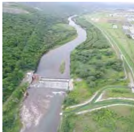
写真 2 - 既設空知川頭首工
