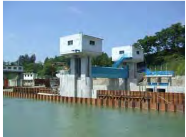
写真-4 P1,P2堰柱部完成状況(H21.10月)
