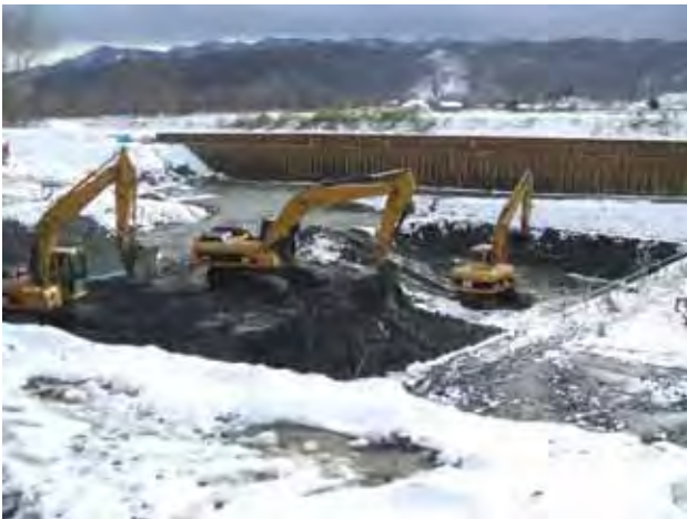
写真-2 頭首工P1,P2堰柱部掘削状況(H20.12月)
