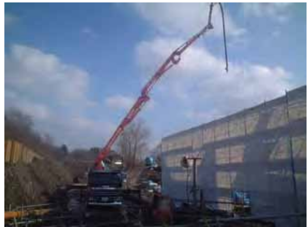
写真-5 P3堰柱部コンクリート打設状況(H21.12月)
