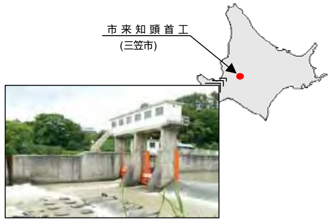
写真-1 既設頭首工の状況
