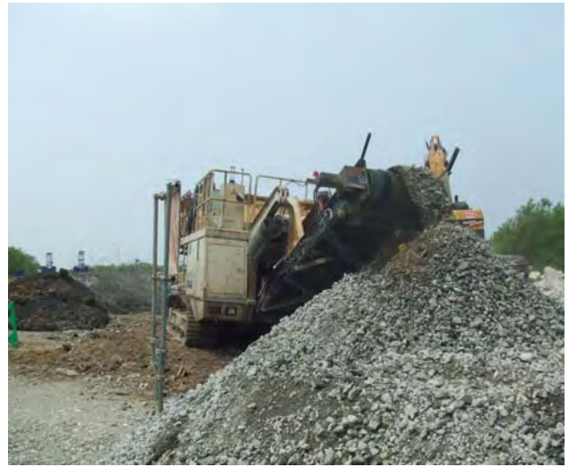
写真－6 骨材再生工施工状況
