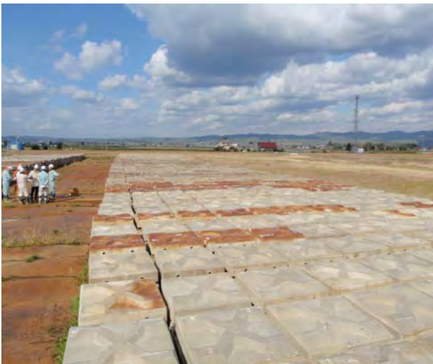
写真－5 護岸ブロック仮置き状況
