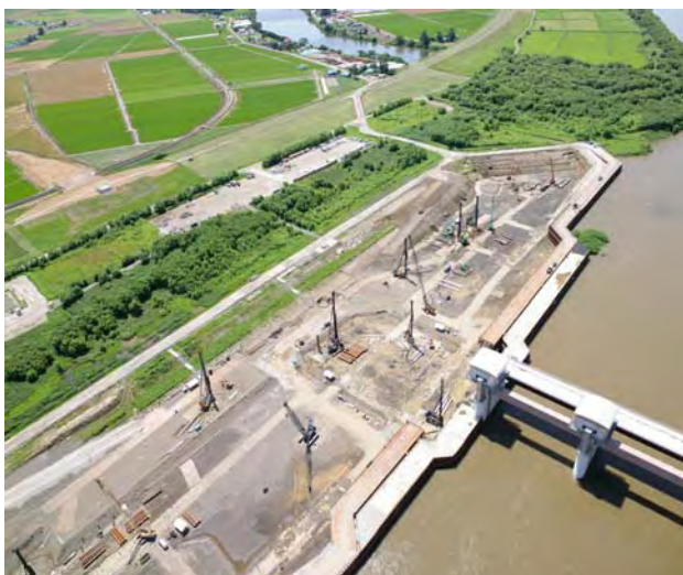
写真-1 締切状況
