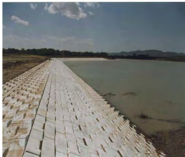
写真-3 河川拡幅部
