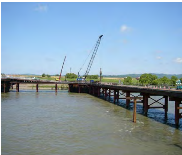
写真-2 締切施工状況
