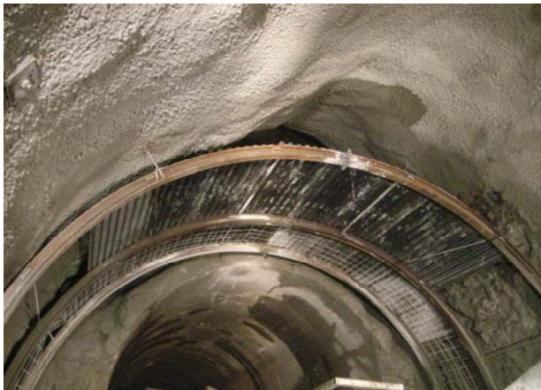
写真-5 鋼製裏型枠設置状況
