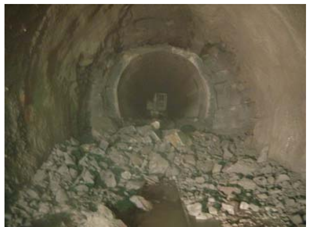
写真-2 破碎された岩塊状況
