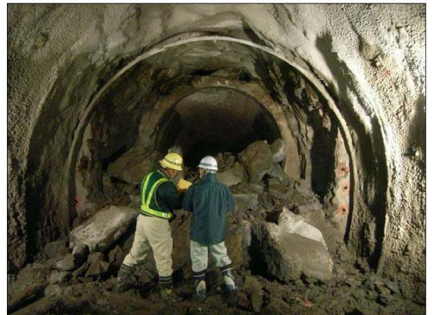
写真-1 発破掘削状況
