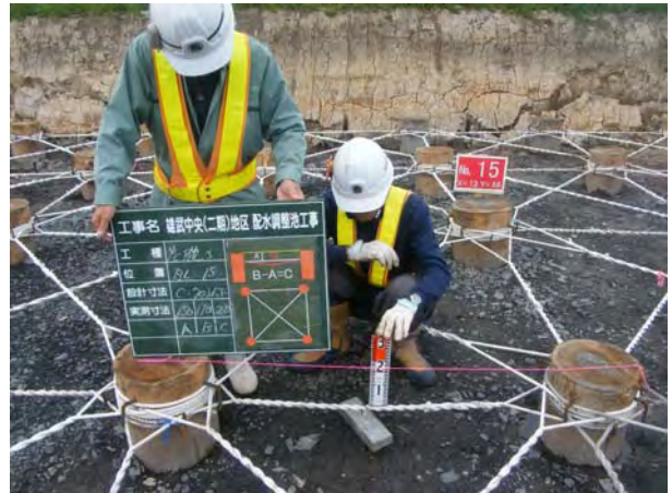
図-8 杭頭連結材たわみ量測定
