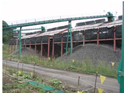
写真-1 遮光ネット設置状況
