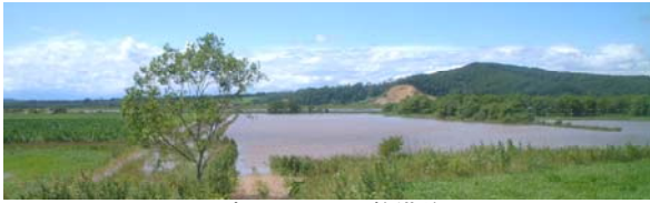
写真-1 置土工整備前
