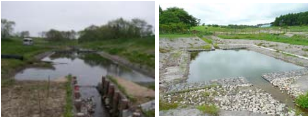
写真-2 第七川排水路排水調整池 写真-3 第七川1号排水路排水調整池
