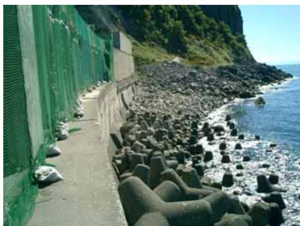
写真-1 消波ブロックの散乱状況
