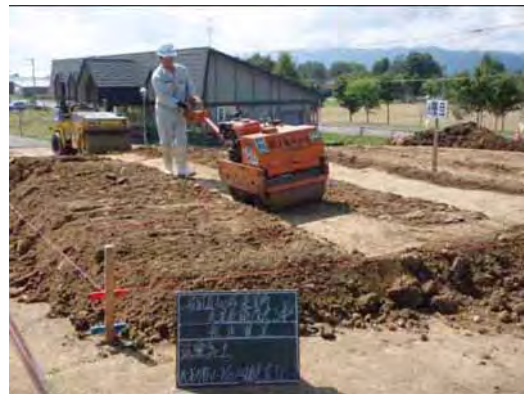
写真-9 試験盛土の転圧状況
