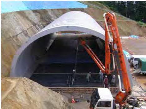
写真-6 インバートの施工状況
