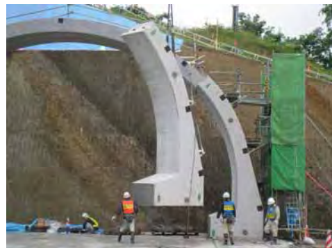
写真-4 サイドウォールの架設状況
