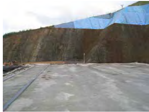
写真-3 基礎工の施工状況
