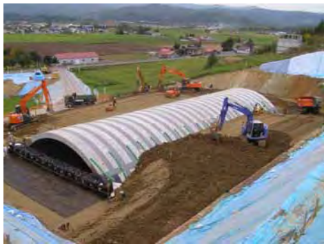
写真-7 裏込め土の施工状況①
