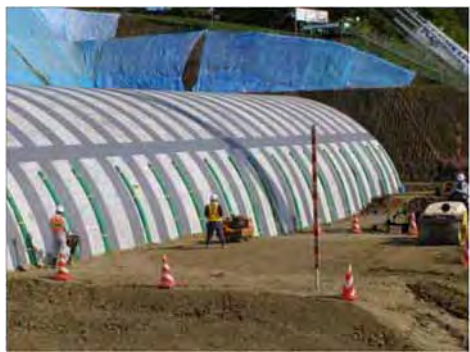
写真-8 裏込め土の施工状況②
