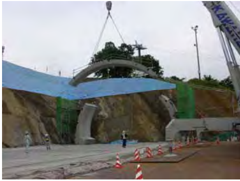
写真-5 ポールトの架設状況
