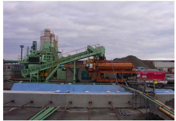
写真-2 改良プラントの設置状況
