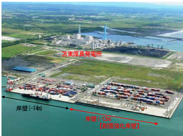
写真-1 苫小牧港東港区中央水路地区
