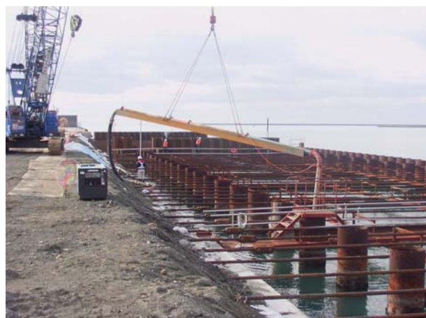
写真-3 改良土の打設状況
