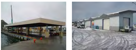
衛生管理施設 防風雪施設
