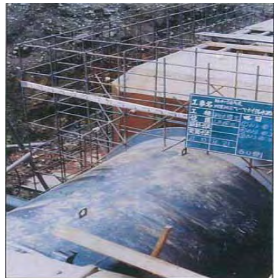
写真-1 施工状況（昭和56年度）
