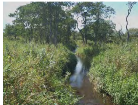
写真-2 河道整備箇所（施工後2年10ヶ月）
