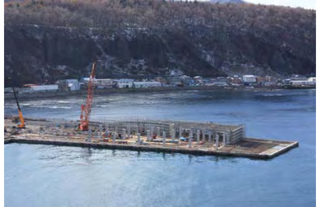
写真-8 工事進捗状況写真(H21. 11. 4撮影)
