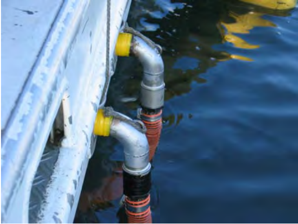
写真-7 船倉水対策状況
