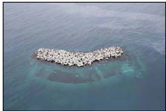
写真-2 高度 200m のラジコンヘリからの空撮 (背後小段付傾斜堤)
