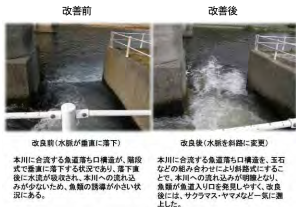
写真-6 真勲別頭首工 魚道入口部の改善状況
