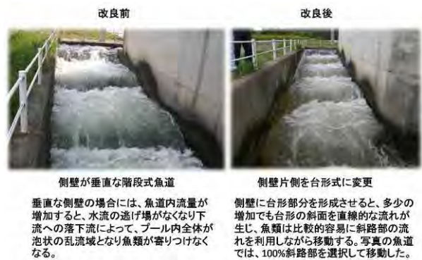
写真-7 真勲別頭首工 魚道内隔壁及び側壁の改善状況
