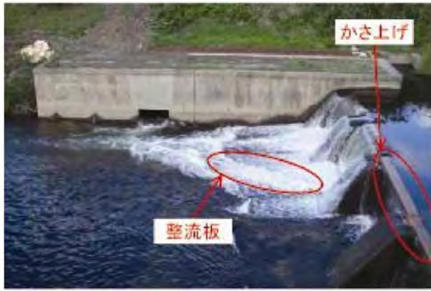
写真-9 上名寄頭首工 魚道入口への流れ込み対策工法
