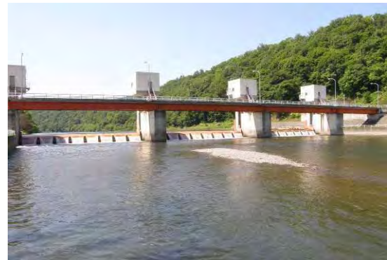
写真-1 真敷別頭首工
