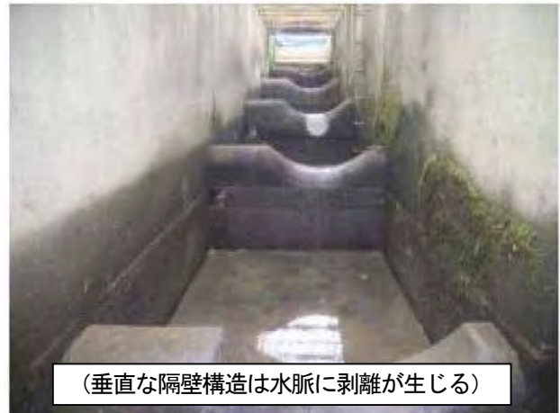
写真-5 魚道隔壁構造
