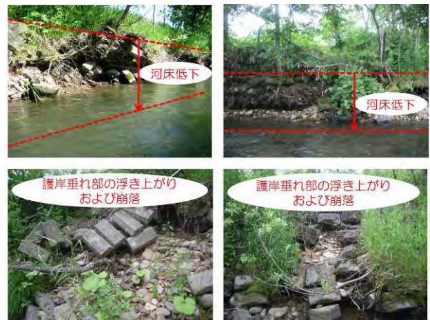
図-6 河床低下状況写真
