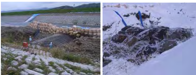
図-17 帯工施工状況
