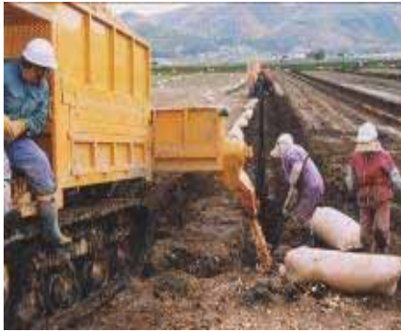
写真-9 暗渠疎水材としての活用
