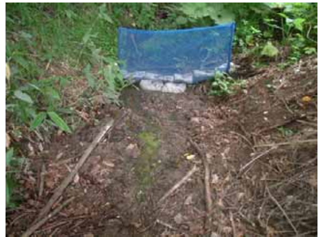
写真-2 工事箇所への移動防止用ネットの設置状況
