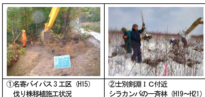
写真-1 緑化資材調達個所の状況
