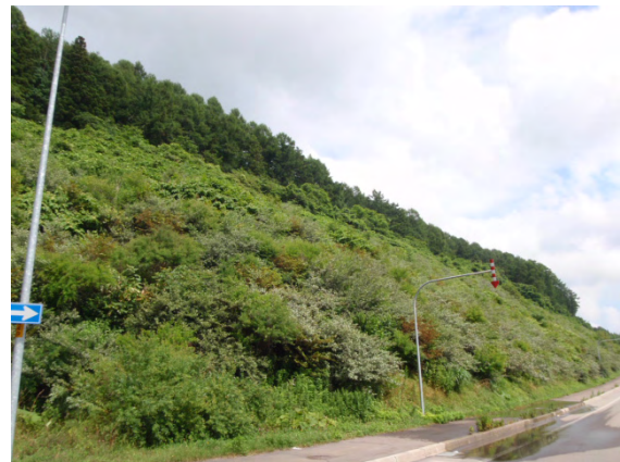
写真-1 側道のり面部の状況
