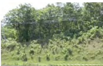
写真-2 植生マット施工箇所
