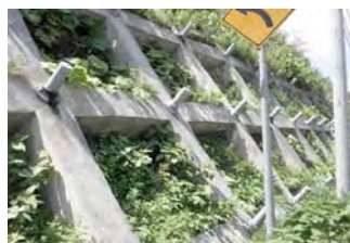
写真-3 フリーフレーム施工箇所
