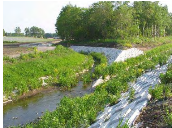
写真-3 植生状況
