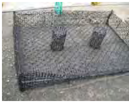
写真-4 通水孔（一例）
