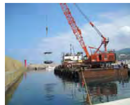
④貝殻礁の据付状況
