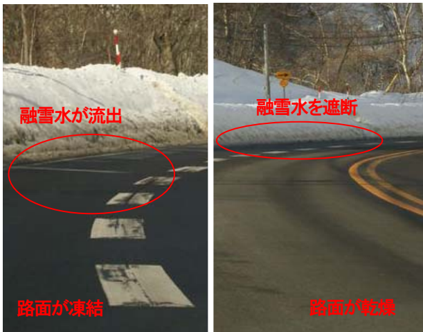
写真-4 縦グルーピング対策前(左)と対策後(右)
