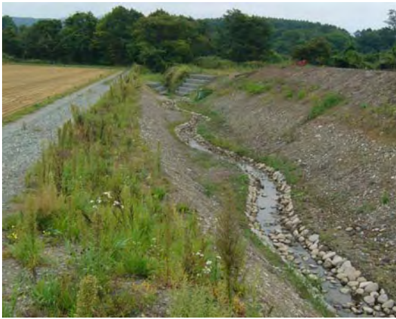
写真-4 環境配慮型排水路
