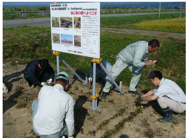
写真-2 PR看板の設置
