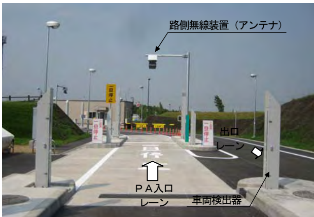
図-7 輪厚スマートIC出入口（札幌向き）
