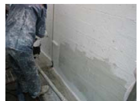
②仕上施工 (ローラー)
