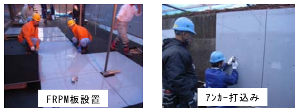
写真-6 パネル系補修工法の施工状況
