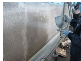
①下塗り施工 (吹付け)
