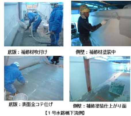
【1号水路橋下流側】
