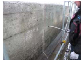
②噴霧器で散水養生
