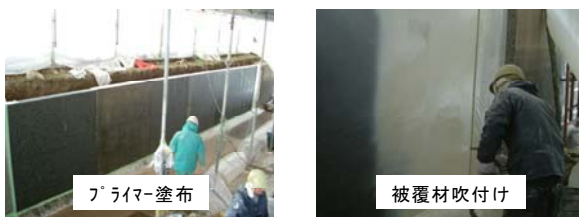
写真-5 樹脂系補修工法の施工状況
