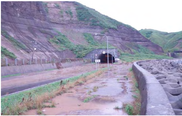
写真-2 道路被災状況 (8月12日撮影)
