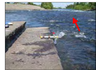
写真-7 水位計設置状況
