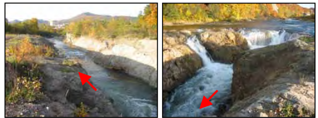
写真-2 河床の露岩化の状況 (藻南公園下流)
