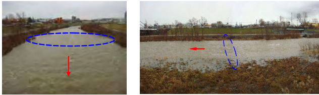
写真-3 12/3 出水直後の帯工地点の状況
