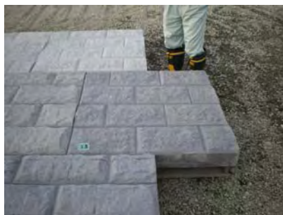
写真-4 護岸表面の試作の様子
