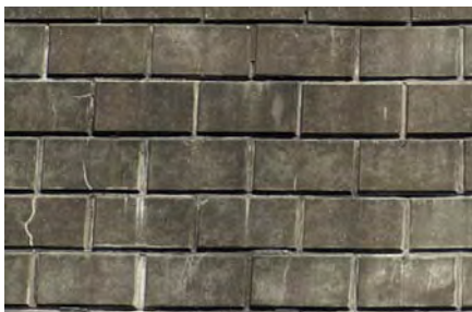
写真-3 現況の護岸の表面
