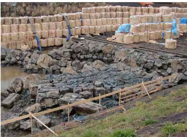
写真-9 分散型落差工施工状況全景 (H22)
