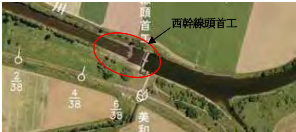
写真-3 H22 施工箇所 (網走川 KP38.3~KP38.5)
