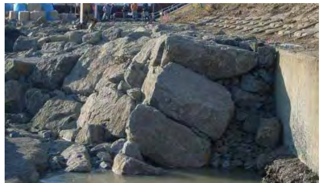
写真-6 施工中石組み断面 (H22)
