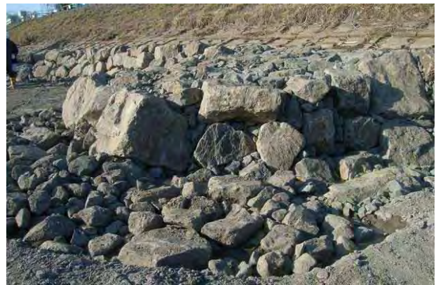
写真-5 水制施工状況 (H22)
