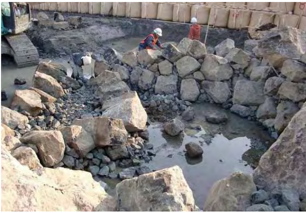
写真-8 分散型落差工施工状況 (H22)
