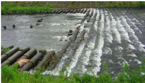
写真-4 西幹線頭首工下流施工前状況 (H22)
