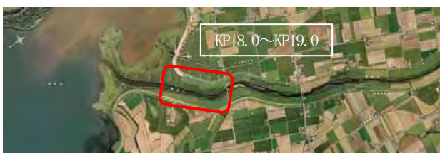
写真-2 H21 施工区間 (網走川 KP18~KP19)
